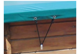
WOOD: Cabiblics-Bänder Doppelbefestigung & Messingösen (Oberflurbecken)
